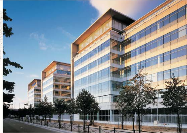
AMF Project Vedior Bis, France
